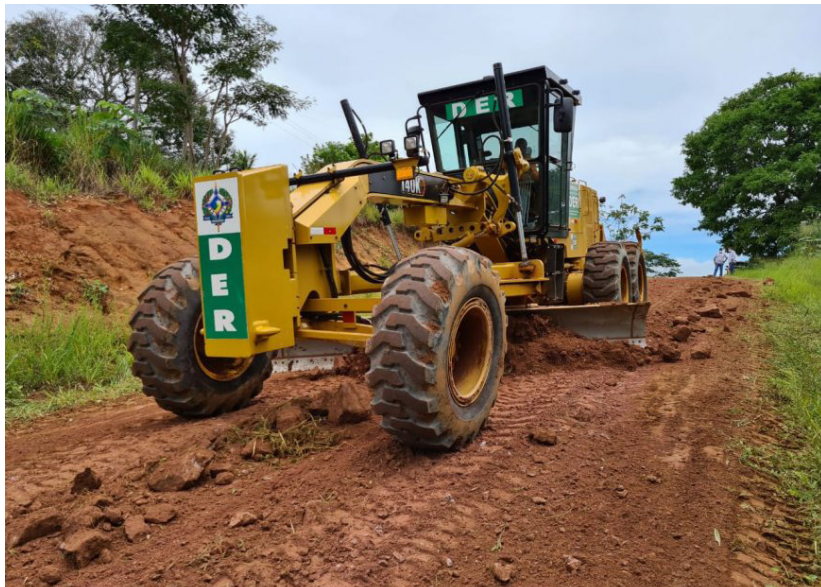
Trabalhos são realizados pela equipe da 5ª Residência Regional do DER
